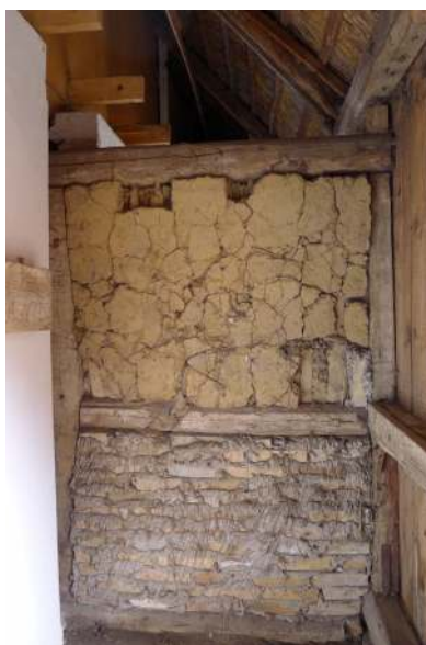
Gammal korsvirkesvägg med utfackning av kline i övre delen och soltorkat tegel försett med halm på ytan inför putsning.
