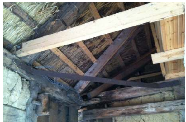
Anslutning portalänga/lolänga utanför arkiven. Uppe till höger skymtar undersida av nytt mellanbjälklag.
