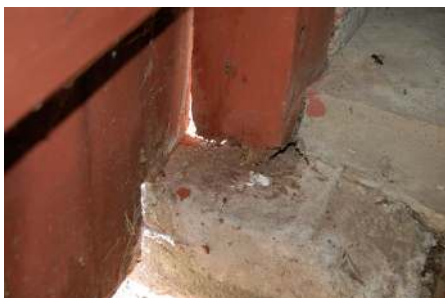
Västra porten mot gården med stolpar som har dålig kontakt med underlaget.
