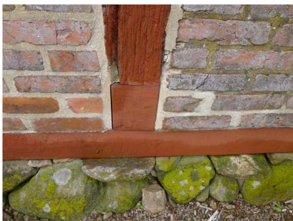
Väl utförd lagning på stallängans södra gavel.
