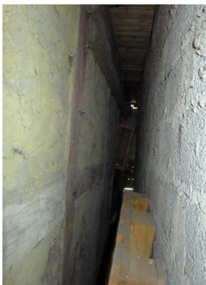
Till vänster gammal vägg mot lölängan till höger arkivvägg av murad lecasten.
