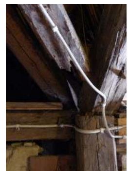
Samma anslutning som ovan sedd från logen.
