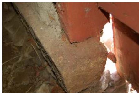
Västra porten mot gården med stolpar som har dålig kontakt med underlaget.
