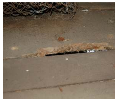
T v : Mossa och trasiga takpannor. Mitten: Fönster med flagnande färg. T h: Insektsangripen golvbräda.
