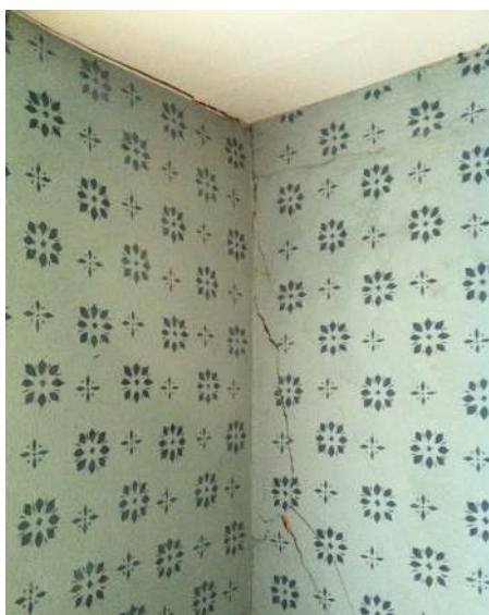
Puttskador i fruns kammare.
