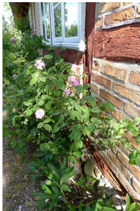
Väggarna kontrolleras under växternas viloperiod.
